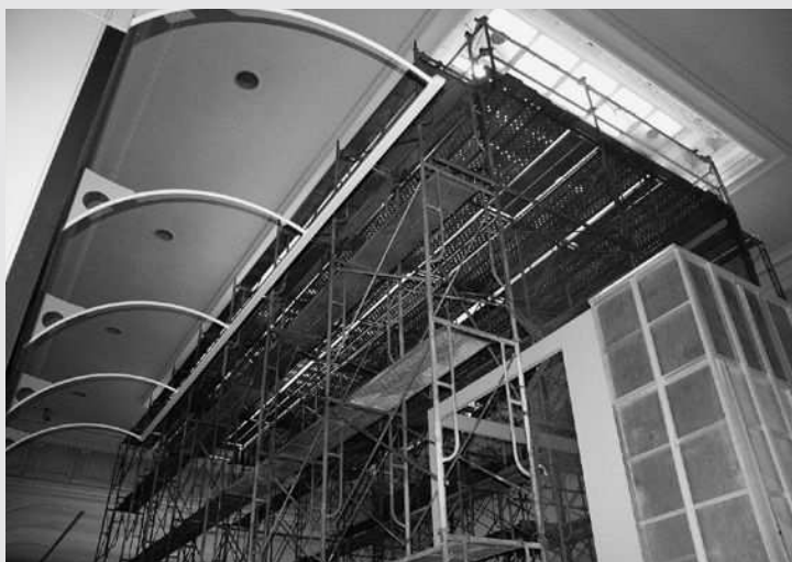
第1室（中央ホール）の工事風景。天井照明改修のための足場が林立している。
